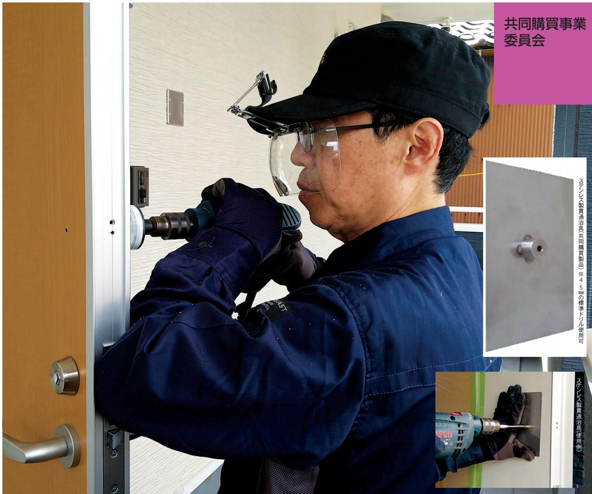
ステンレス製貫通治具共同購買製品 ※4.5mmの標準ドリル使用可
