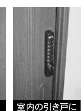
室内の引き戸に
